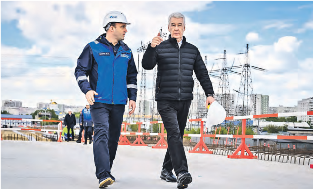
16 мая. Мэр столицы Сергей Собянин осматрел работы по строительству путепровода, связывающего улицу Костромская и Юрловский проезд на северо-востоке Москвы
