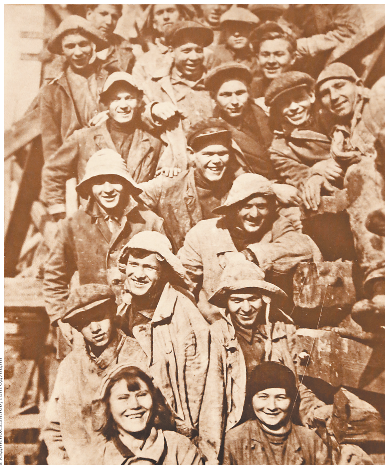
Первые строители метро поднимали вагонетки по деревянным лестницам.
