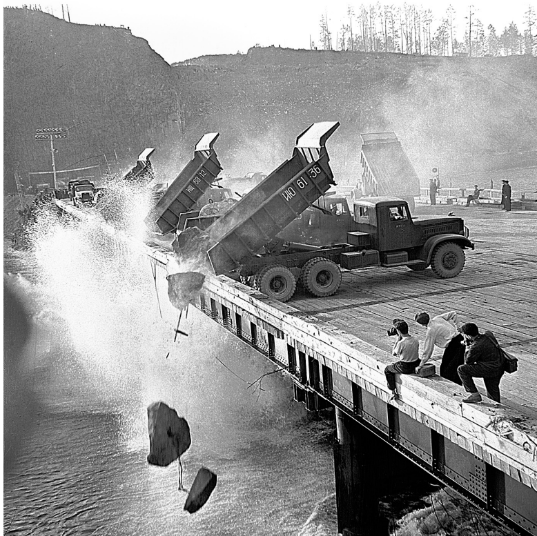
Строительство Братской ГЭС: начало перекрытия реки Ангары, 1 июня 1959 г. Фото М. Минеева/Фотохроника ТАСС
