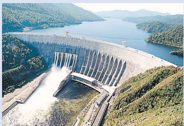
САЯНО-ШУШЕНСКАЯ Установленная мощность: 6400 МВт Высота плотины: 242 м Где находится: р. Енисей, Хакасия
