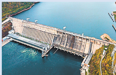
КРАСНОЯРСКАЯ Установленная мощность: 6000 МВт Высота плотины: 128 м Где находится: р. Енисей, Красноярский край
