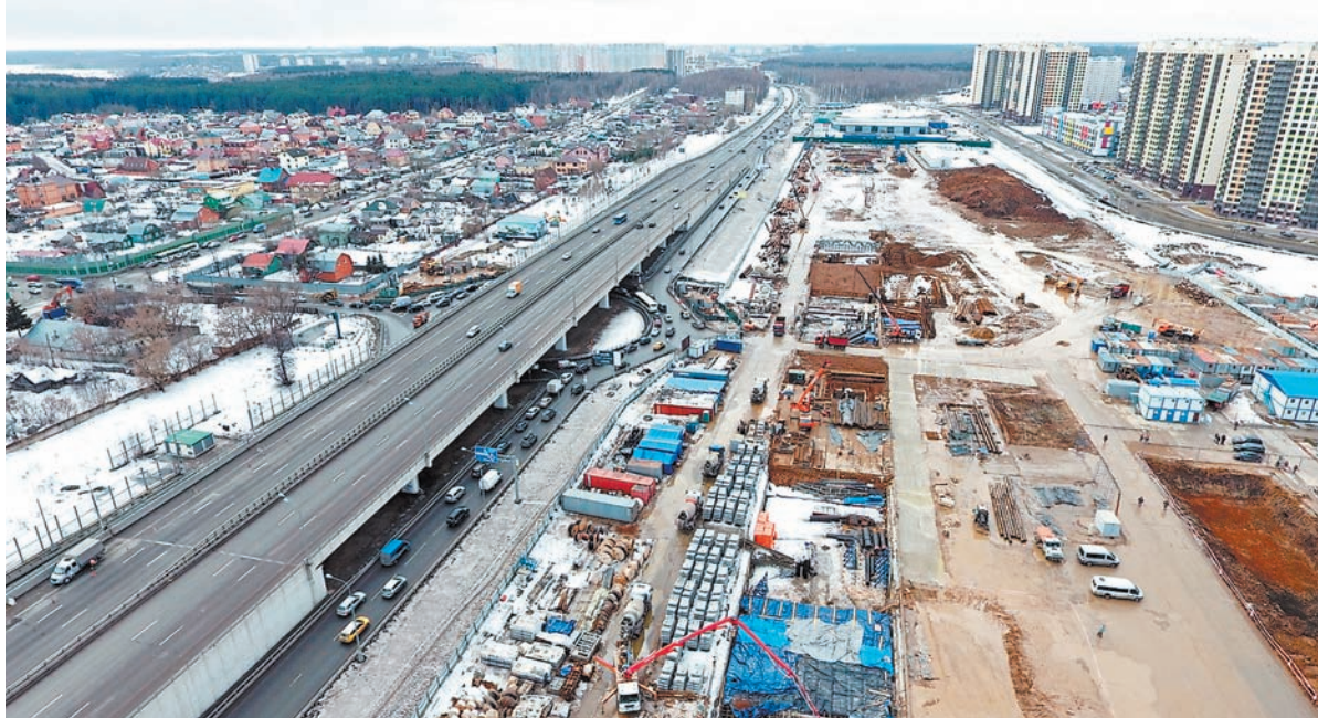
Так сейчас выглядит Киевское шоссе в районе станции метро «Рассказовка».
