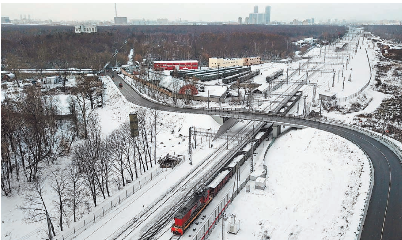
Богородский путепровод теперь позволяет без проблем перемещаться из одного района в другой.
