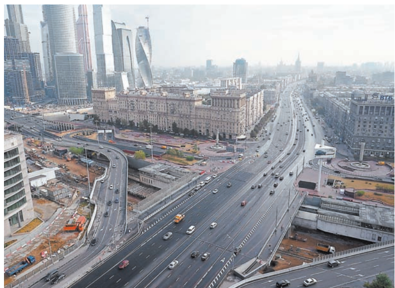
Новый Можайский путепровод сможет выдерживать транспортную нагрузку МЦК, метро и ТТК.
